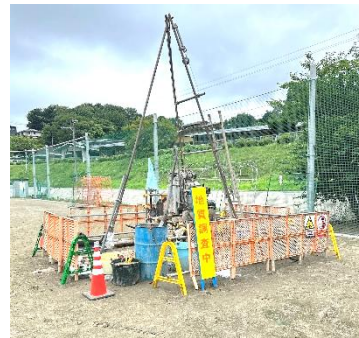
ボーリング調査の様子
