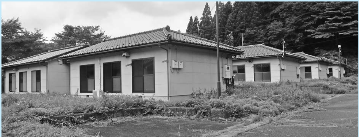
村営住宅として終わりを迎える前田団地
