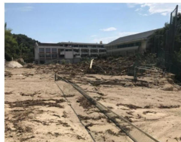
平成30年 7 月豪雨 建物への土砂流入
