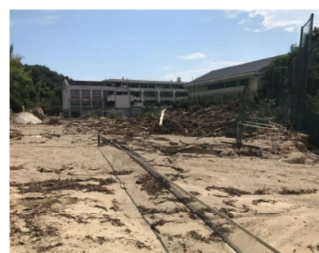
平成30年7月豪雨 建物への土砂流入
