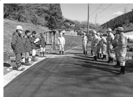
側溝を新設した村道唐露葉貫線
