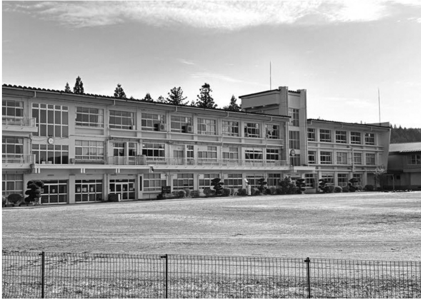
数年後に解体される中学校の跡地利用に課題が残る
