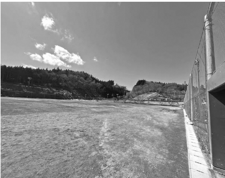
新たに建設予定地となった青少年広場
