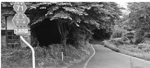
自動車が、すれ違いできないほど狭い県道71号線
