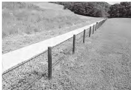
鹿角平キャンプ場に設置された木柵は、木材を使用することで景観に配慮しています
