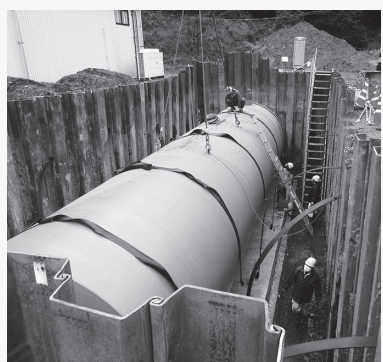
設置された大容量の防火水槽
