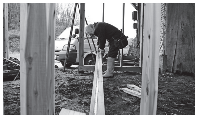
現場で採寸し、状況に合わせて材料を切ります
