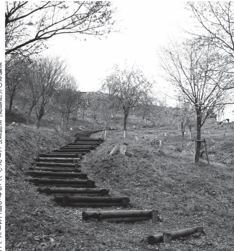
修繕後の木製階段。来園者がより安心して歩ける道になりました
