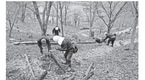
老朽化した階段を撤去し、丸太を設置します
