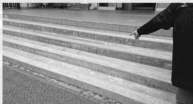
こどもセンター玄関階段補修工事 ほか 115万円
