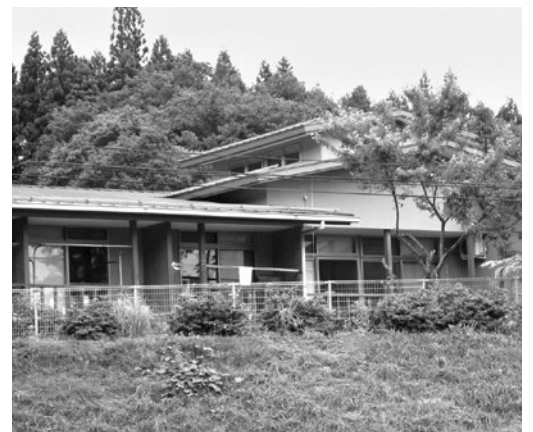
増築が検討される居住棟(ひだまり荘内)
