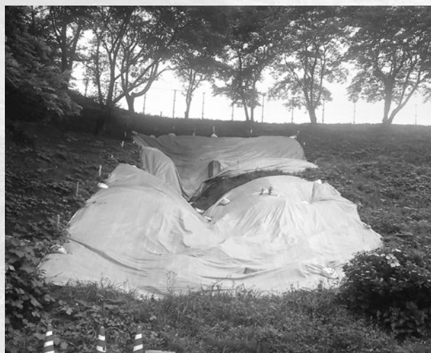
青少年広場法面補修工事
