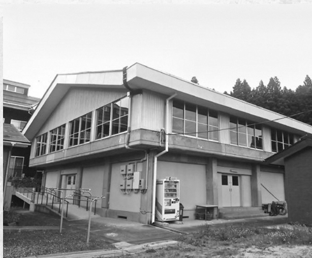
西山体育館屋根葺替工事
