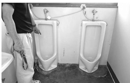
鮫川中体育館の屋外トイレ
