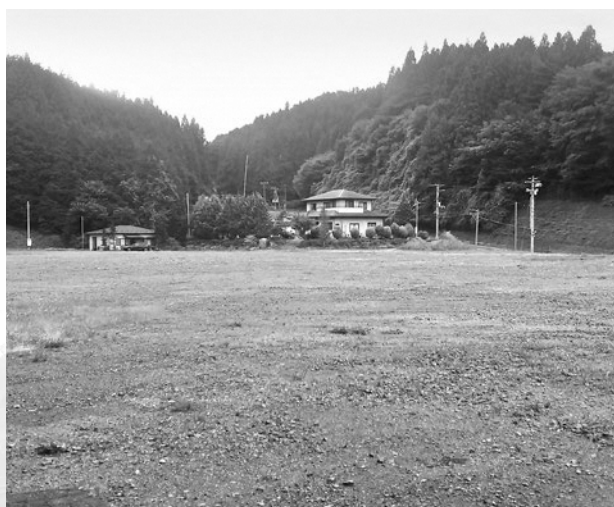
見渡住宅分譲地造成工事
