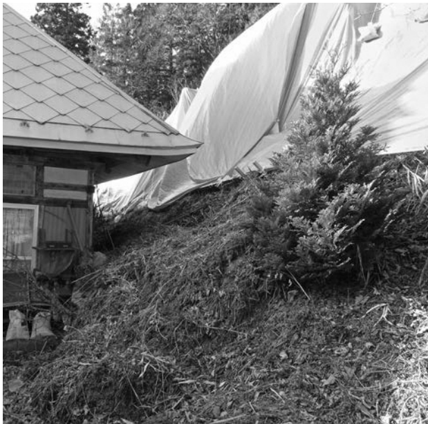
家屋への崩壊が危ぶまれる急傾斜地
