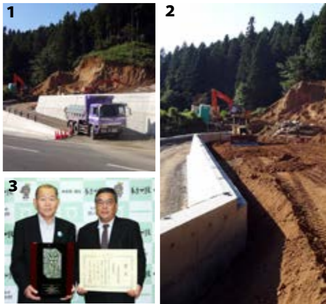
1・2_ 村内に造成中の現場。畑付の分譲住宅などおよそ15棟が並ぶ予定。若い世代や都市部から来た人が、村の良いところを体感しながら住める場所を計画しています/3_ 湯座建設は、機材を自前で揃え、「何でもやれる」建設会社です。優秀な工事から、9月に県知事表彰も受賞しました
