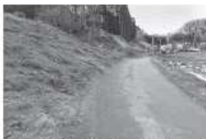
農道改良工事 藪地内
