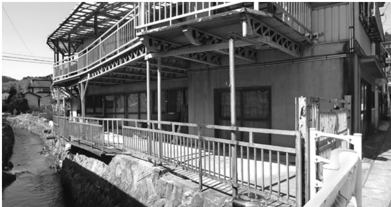
空き家除却・整備(道少田地内)
