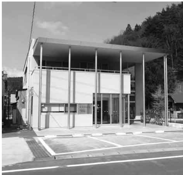
災害復旧工事が完了した村図書館
