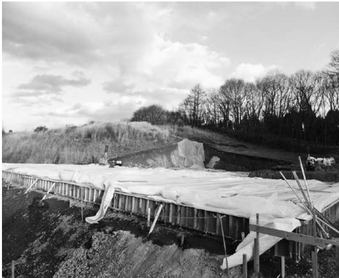
安全が求められる焼却炉設置予定地
