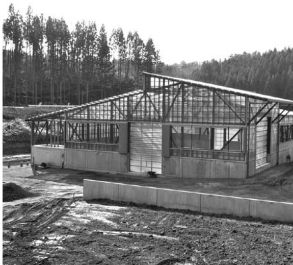
8月の稼働を待つ「堆肥センター」
