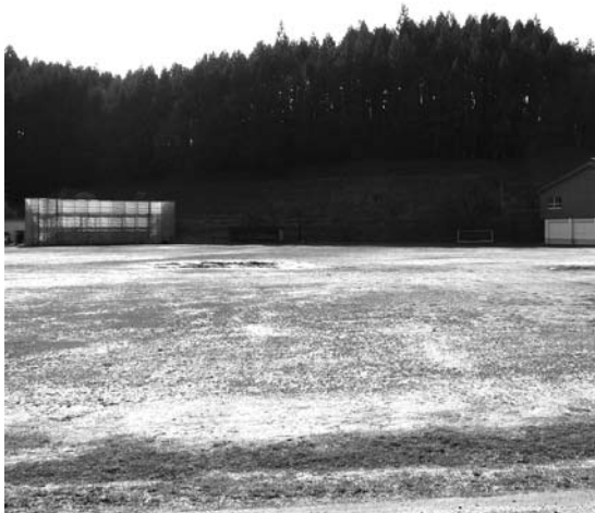
緊急ヘリポート・防災倉庫が整備される村民グラウンド
