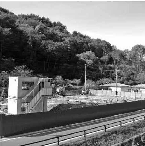
公営住宅1・2・3号建設工事 ～広畑団地～
