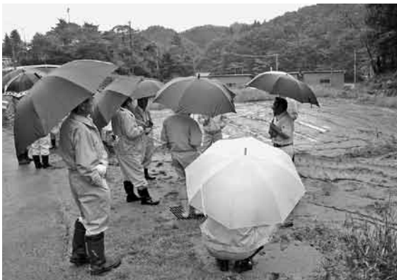
校庭・園庭など除染の表土が搬入された住宅団地造成地(西山字水口地内)
