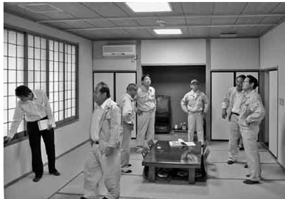
復旧工事により、天井など修復された2階和室交流施設「ほっとはうす・さめがわ」
