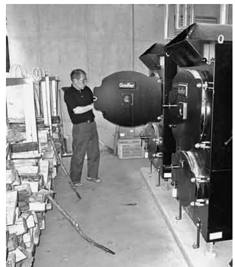
新エネルギー源として注目される薪ボイラー(さざり荘の暖房システム)
