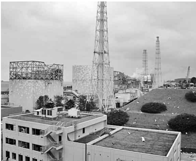
未だ収束が見えぬ福島第一原子力発電所の事故現場 (東京電力株式会社 提供)
