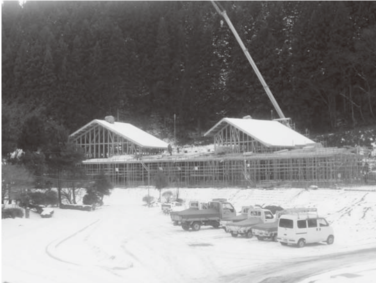
急ピッチで進められる保養施設（さざり荘）現場
