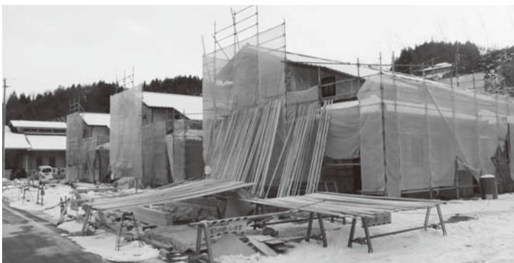
公営住宅建設現場 （1棟2戸建を3棟建築）
