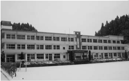
耐震改修された鮫川小学校
