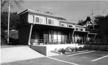
水口定住促進住宅
