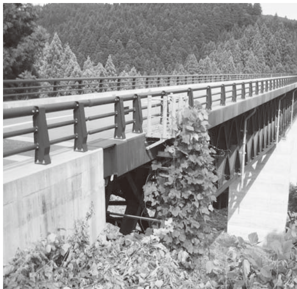
村道江竜田塙線（江竜田大橋）
