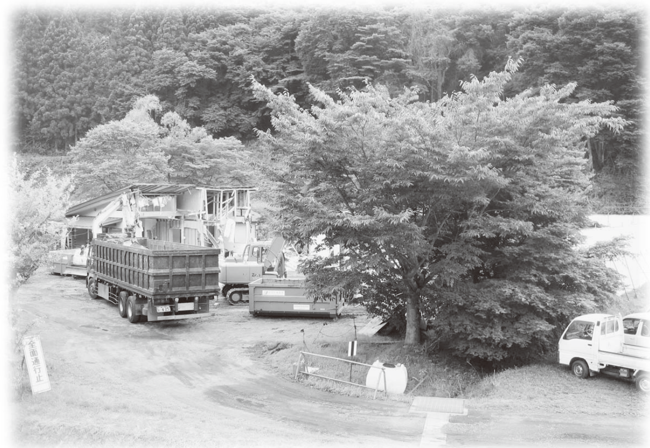
新装改築に期待が高まる村民保養施設建設現場
