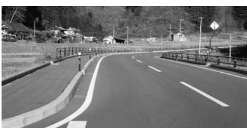
高い品質管理が求められる公共土木工事
