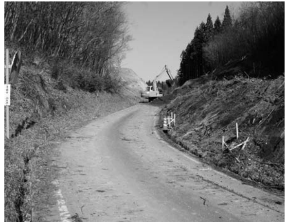
大型改良工事が着工された林道酒垂宝木線
