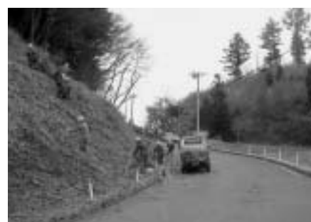
雇用対策で実施される支障木伐採
