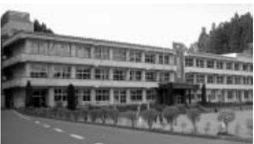
耐震補強改修工事が行われる鮫川小学校校舎
