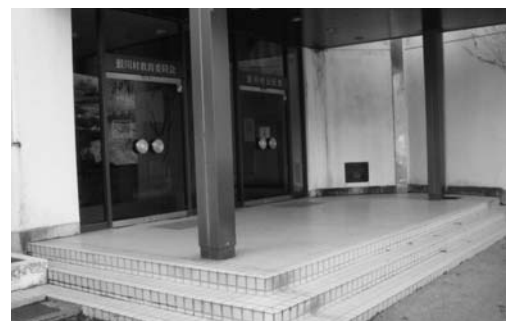
公民館改修工事
