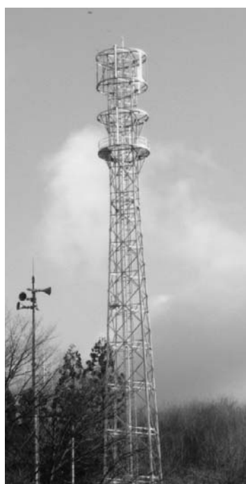
建設が進む移動通信用鉄塔施設
