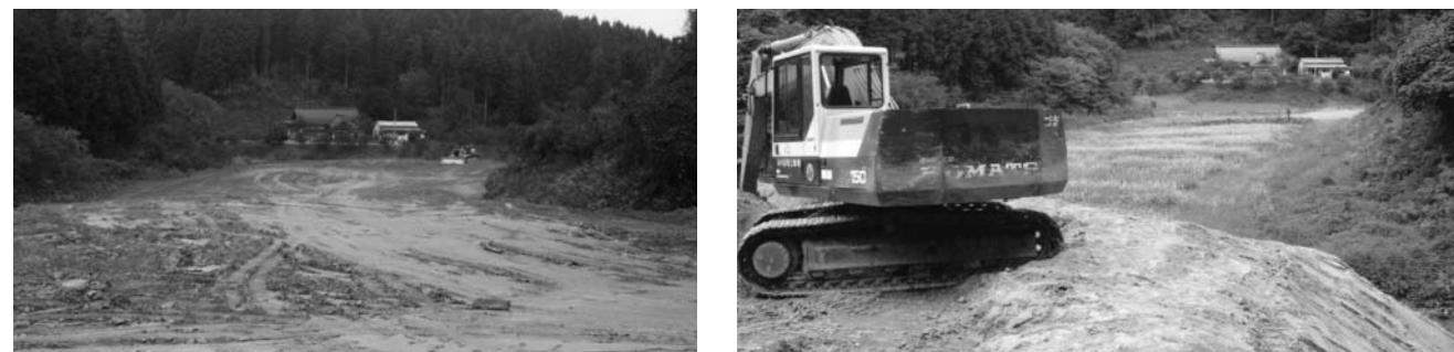
堆肥センター建設予定地大字富田字八斗蒔地内
