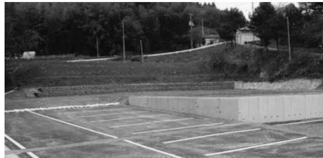
定住促進住宅造成工事（水口地内）
