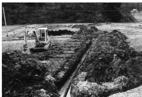
暗渠排水事業
