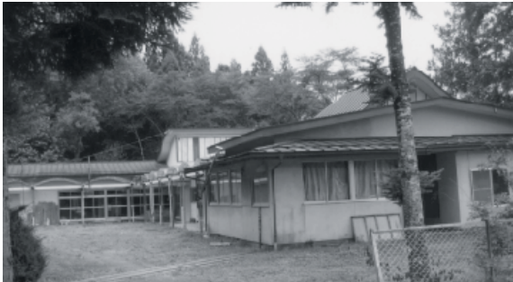
旧鮫川保育所の一部が撤去されて書類等保管倉庫が建築される
