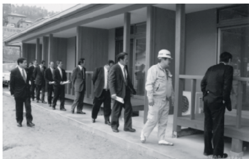
高齢者向け優良賃貸住宅建設現場
