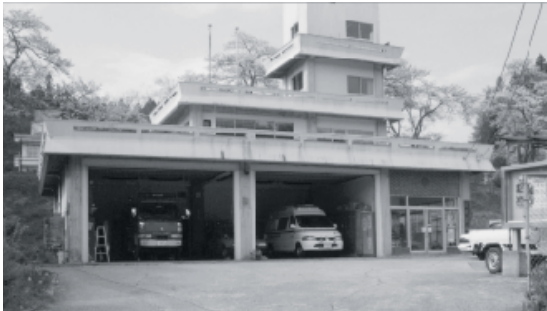
棚倉消防署鮫川分署
