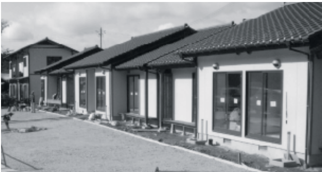
建設中の渡瀬公営住宅
