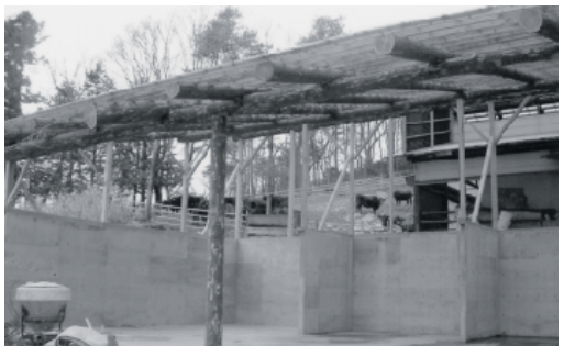
畜産農家が整備した堆肥舎
