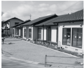
まちづくり交付金で整備された渡瀬公営住宅
