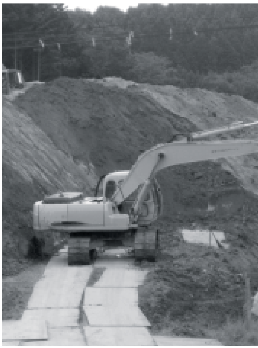
国道349号鮫川バイパス改築工事・西前田地内
