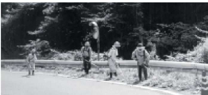
道路除草作業
