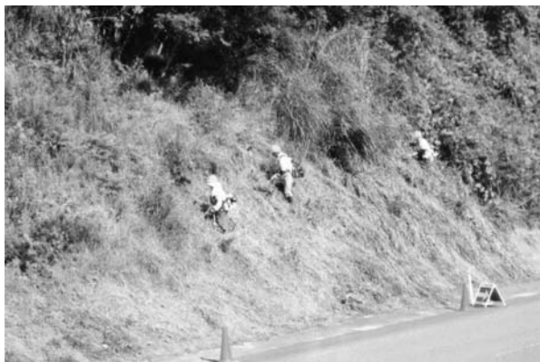
法面の除草作業
