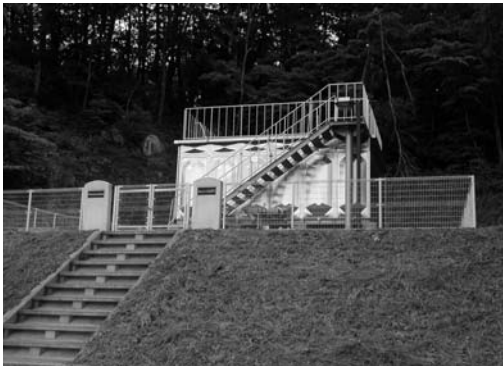
塚本地区水道配水池（塚本地内）
