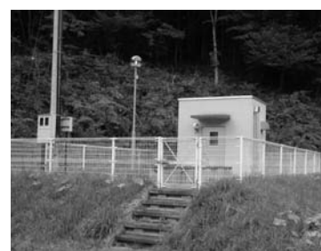
鯨川簡易水道第3水源（鍛木田地内）
