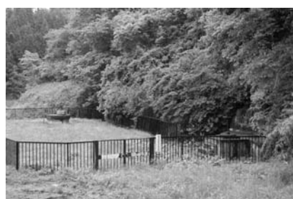
鯨川簡易水道第1・2水源（鍛木田地内）
