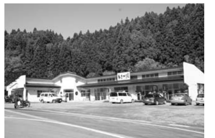
名称…鮫川村食と農の学習施設、農産物加工・直売所「手・まめ・館」／施設位置…鮫川村大字赤坂中野字巡ヶ作116番地／主な施設…豆腐加工室、納豆加工室、直売施設、食堂・体験室、食品加工室／平成17年11月6日オープン
