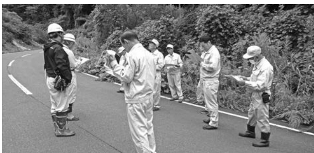
大規模な地すべりが発生した村道内ヶ竜滝ノ下線
