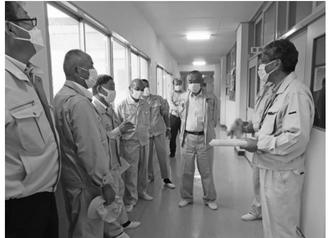
鮫川中学校 校舎3階廊下 天井修繕工事
