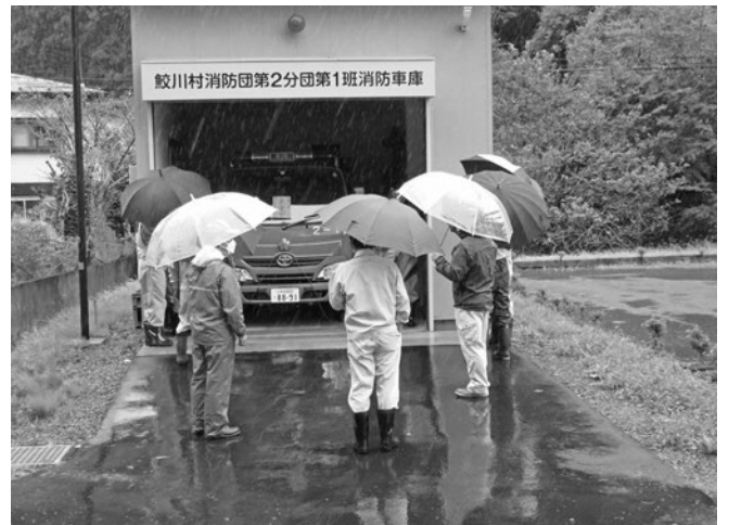
酒垂消防車庫 新築工事
