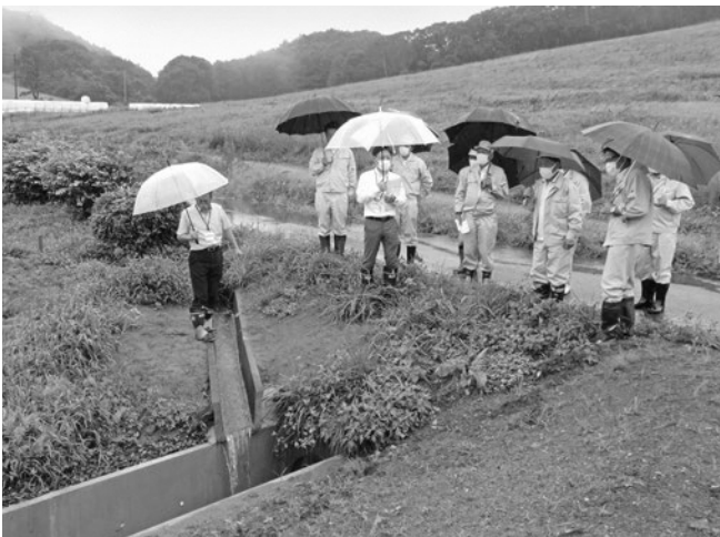
鹿角平観光牧場 排水路整備工事
