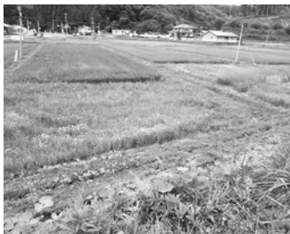
望まれる維持工事箇所
