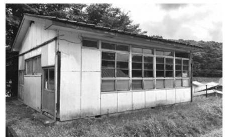
解体される旧青生野小学校物置
