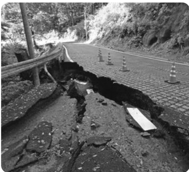
元年災 公共土木施設災害復旧工事 2億6343万円
