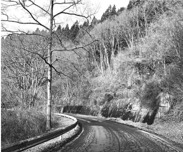
人口減少で負担となる除草作業や支障木の伐採
