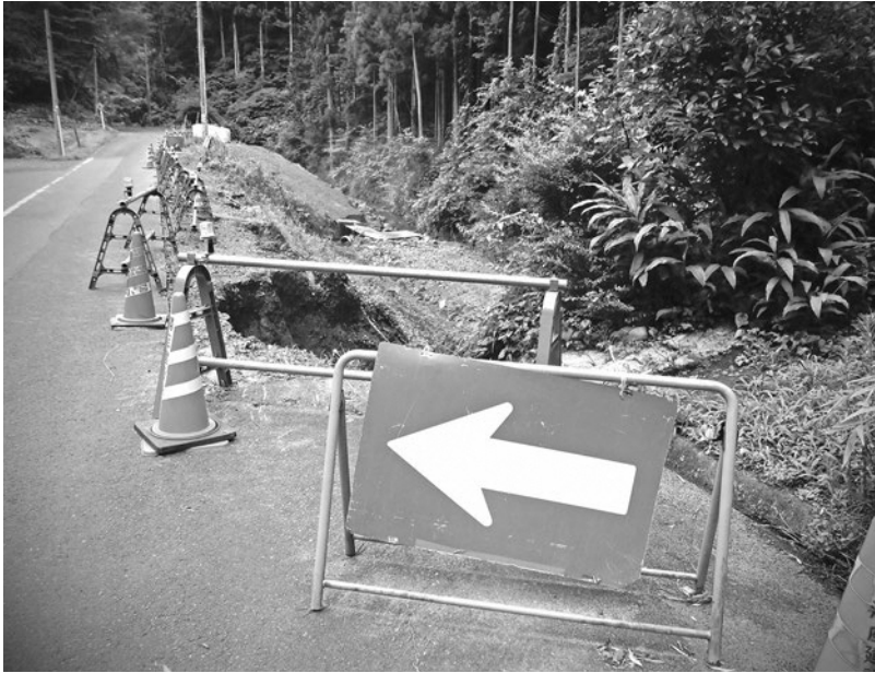
再々工期延長の災害現場
