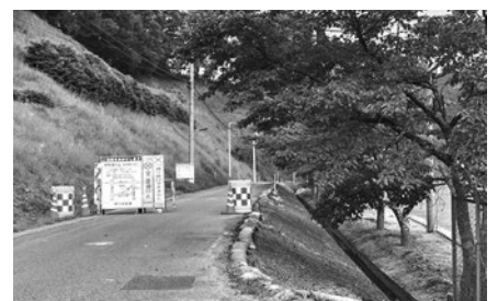
舗装が補修される青少年広場線
