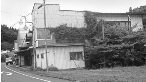
早期対応が必要な建物
