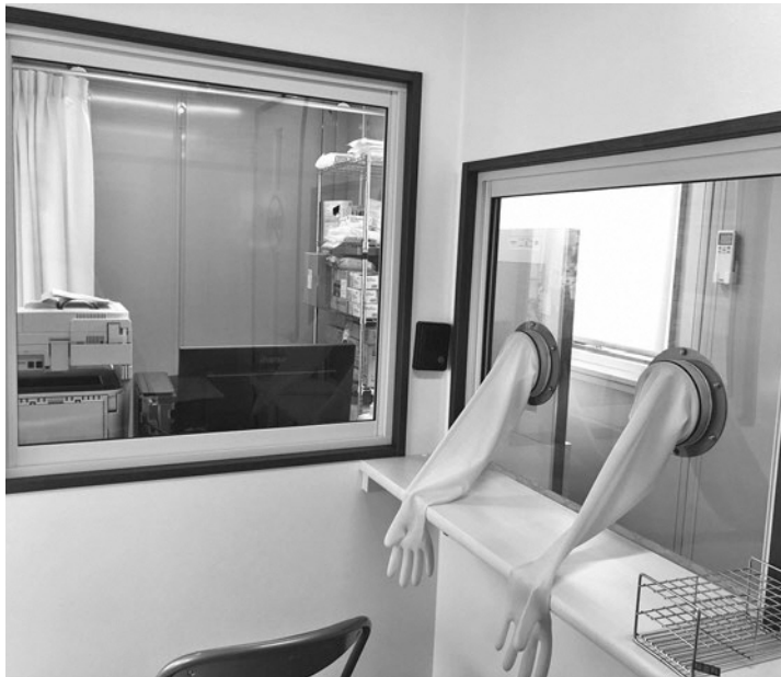
埴厚生病院に設置されている検査センター
