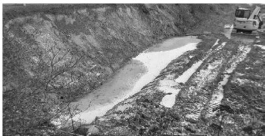
公共土木災害復旧工事状況
