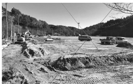
青少年広場の大規模改修工事
