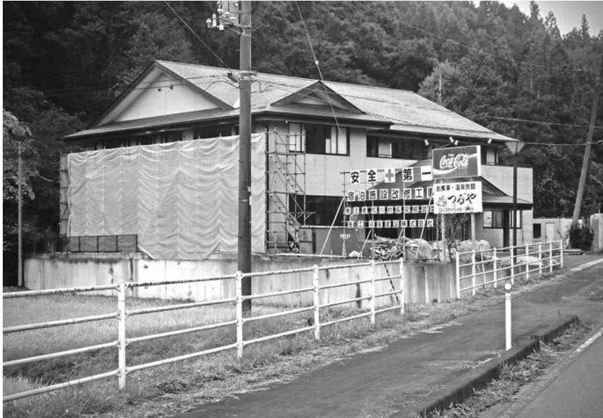
開設が期待される宿泊施設
