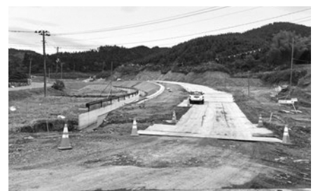
危険箇所が改良された国道289号線
