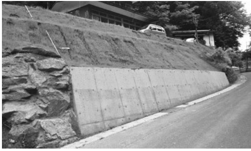
復旧工事が完了した被災箇所
