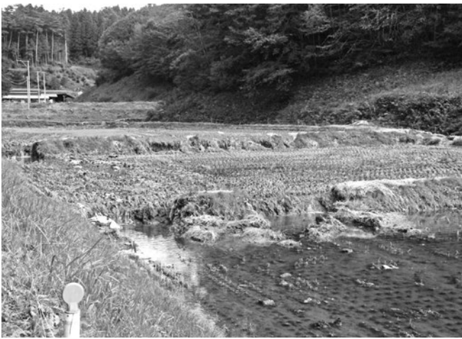
▲ 水田の畦畔崩落被害
