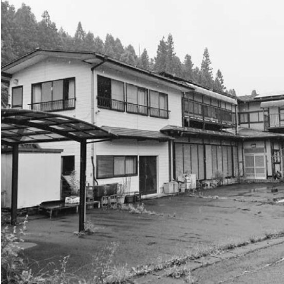
福祉施設として改修が予定されている旧保養施設
