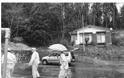
解体予定の青生野小教職員住宅
