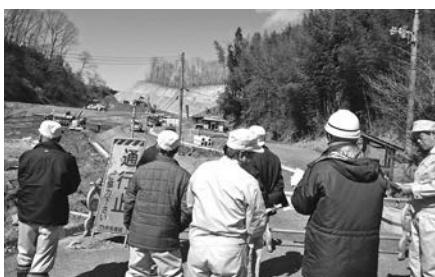
水口大沢線改良工事
