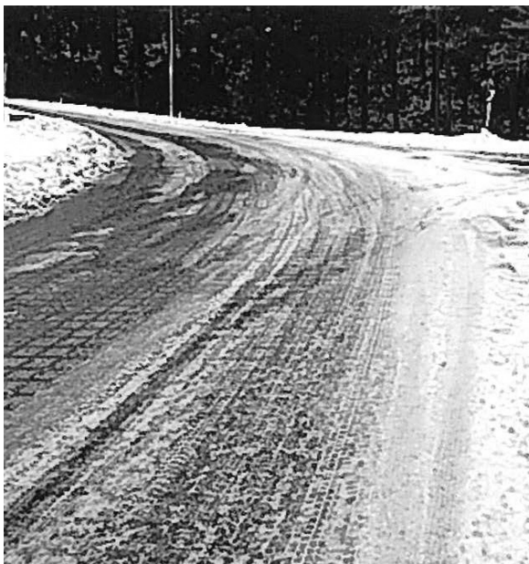
除雪6日後の又石地内の道路状況
