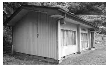
一部助成を受けて改修する集会所
