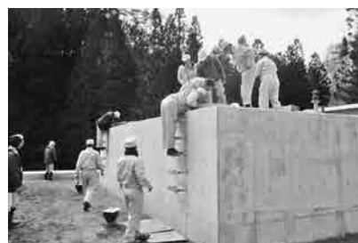
富田・楸木田配水池
