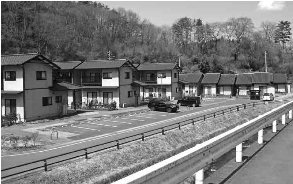
定住を図るための広畑村営住宅
