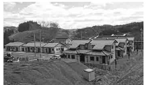
公営住宅宿ノ入団地
