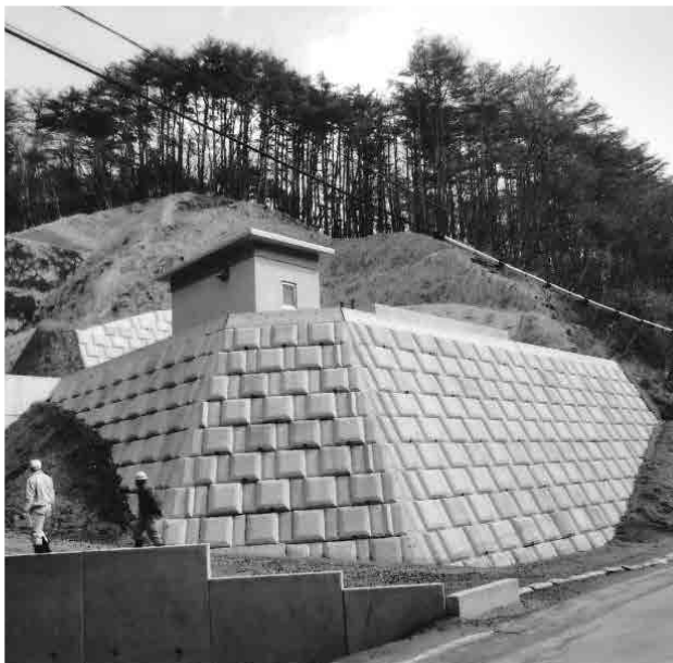
完成した鍬木田配水池(富田地区)
