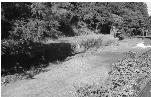
建物が解体撤去された旧西島旅館跡地
